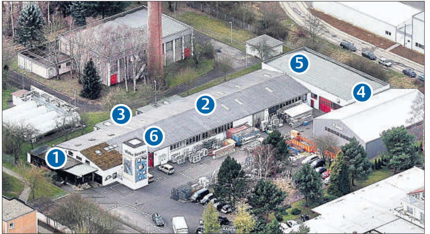
Hier werden über 20 000 Fenster im Jahr gebaut: Die Firma Walter Fenster + Türen an der Theodor-Haubach-Straße.
